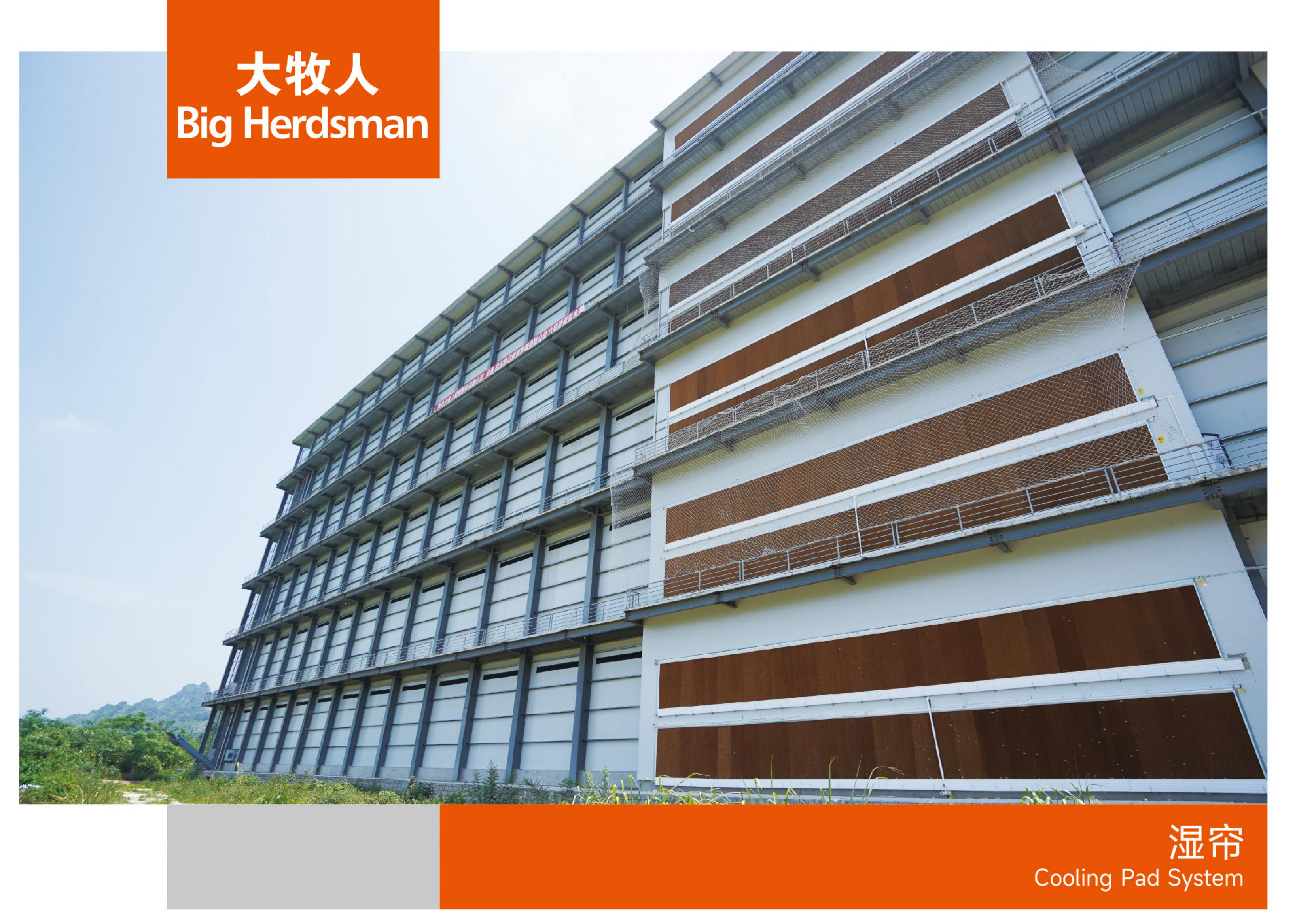
湿帘主要用于禽舍降温、增湿。主要采用"湿帘—负压风机"模式,其工作原理:系统的降温过程是在其核心"湿帘纸"内完成的。当室外热空气被风机抽吸进入布满冷却水的湿帘纸时,冷却水由液态转化成气态的水分子,吸收空气中大量的热能从而使空气温度迅速下降,与室内的热空气混合后,通过负压风机排出室外。
